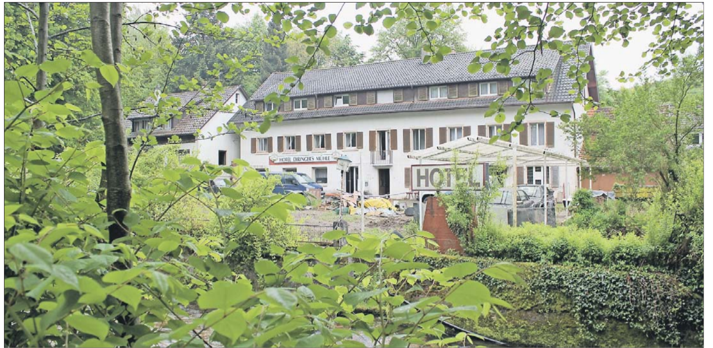
Die ehemalige Hotel-Immobilie wird abgerissen. Auf dem Gelände soll eine Markt-Scheune entstehen.
