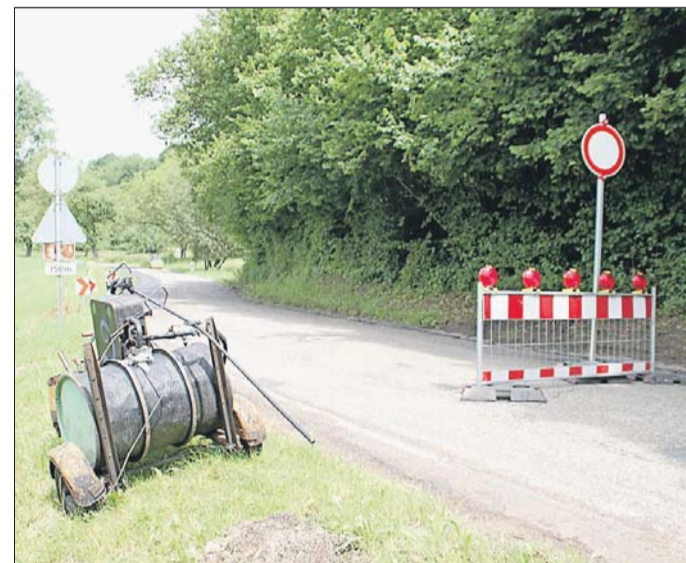
Vollsperrung: Auf dem Herrenpfädel wird die Splittung der Fahrbahn vorbereitet.
