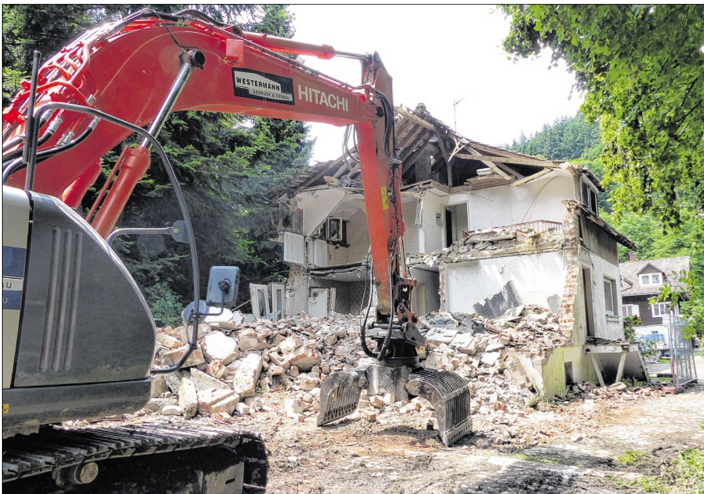
PLATZ FÜR DIE NATURPARK-MARKTSCHEUNE: An der Geroldsauer Mühle laufen die Abrissarbeiten. Der Unternehmer Martin Weingärtner plant auf dem Areal an der B 500 einen Holzneubau mit Gastronomie zur Vermarktung regionaler Produkte. Foto: Krause
