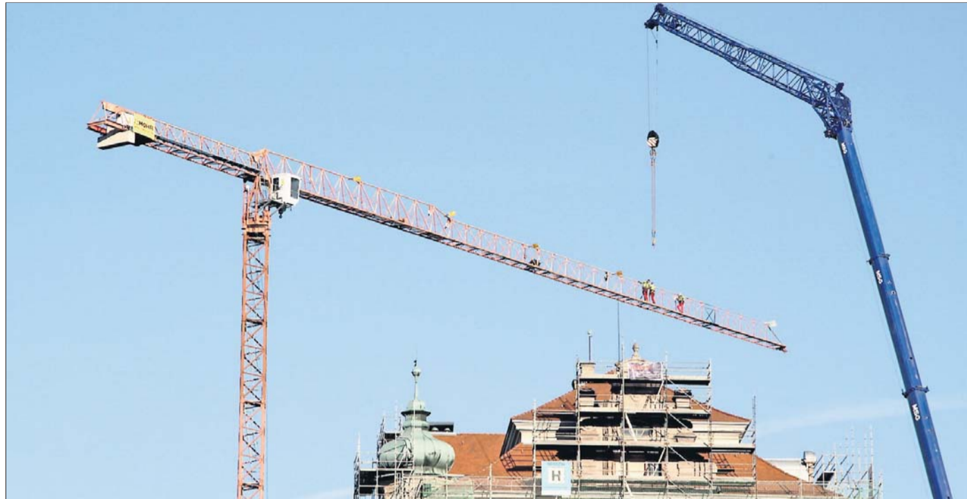
Der Abbau des Drehkrans (links) durch Mitarbeiter beginnt am gestrigen Morgen in luftiger Höhe.
