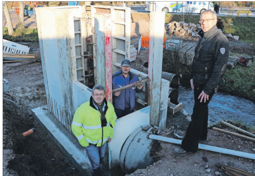
Bauherr Martin Weingärtner (links) mit seinem Bruder Roland (rechts) vor dem Steigschacht, der aktuell gebaut wird.
