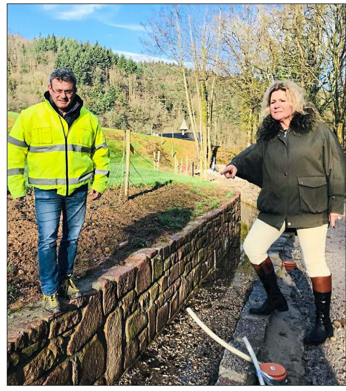
AUS STEINEN der alten Mühle wurde der Kanal gebaut, den Renate und Martin Weingärtner in Augenschein nehmen.
